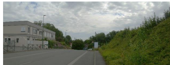
Photo 2 . Vue du Site en vis à vis du Collège Jean Monnet – Antea Group
