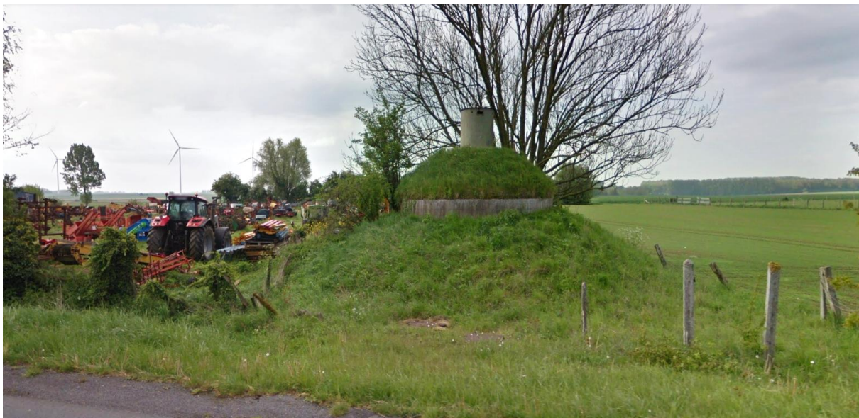
Figure 21 : Vue sur le réservoir d'eau depuis la RD 939 – Source : Google Maps
