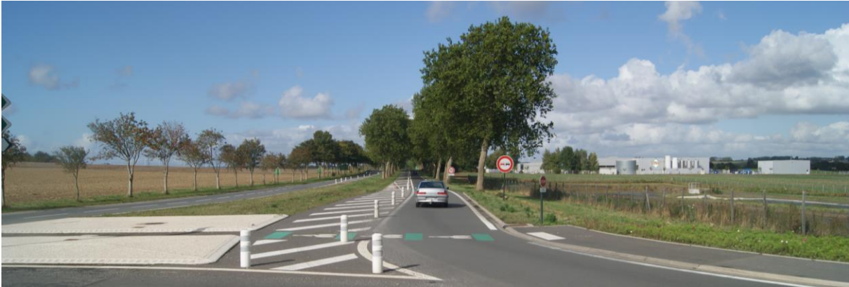
Figure 4 : Vue sur la RD 939 avec à gauche le site d'étude et à droite la zone d'activités avec Brioche Pasquier - Source Antea Group
