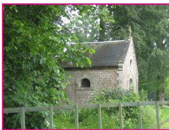
98- Chapelle (enceinte du château)
