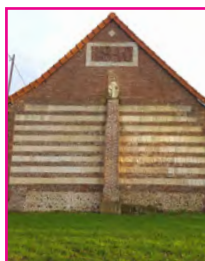
210- Vierge et maison remarquable
